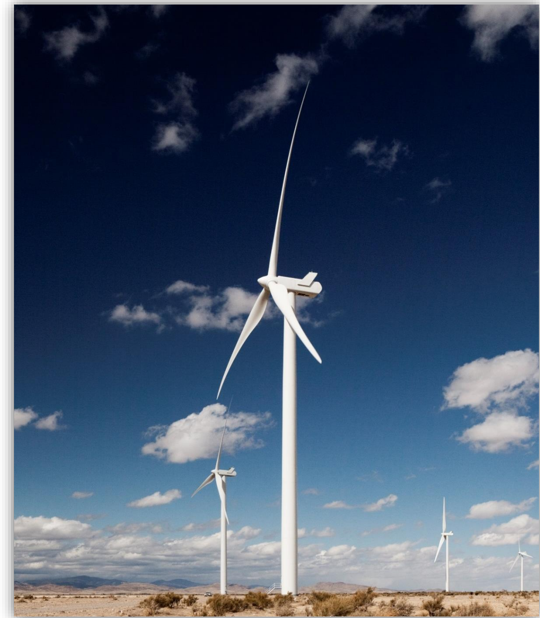
Photographie d'une éolienne
